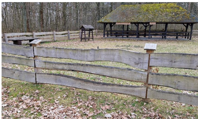
Rys. 2. Przykład ogrodzenia z desek dębowych – w wersji z 3 deskami poziomymi
